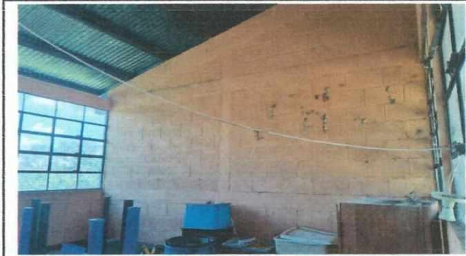
Foto 4: MEJORAMIENTO DE PINTURA EN PAREDES INTERIORES DEL ESTABLECIMIENTO
